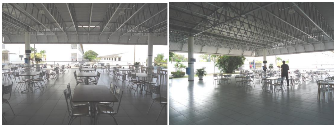
Figura 33 - Imagens do mini shopping da Unidade Acadêmica de Itabaiana Fonte: Cadernos de Infraestrutura – Departamento de Infraestrutura e Material - DIM (2017)
